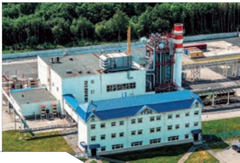
Цех ПВГС (цех пароводогаснабжения, участок газотурбинной установки). Газотурбинная установка (ГТУ) цеха пароводогаснабжения производит пар и электричество
