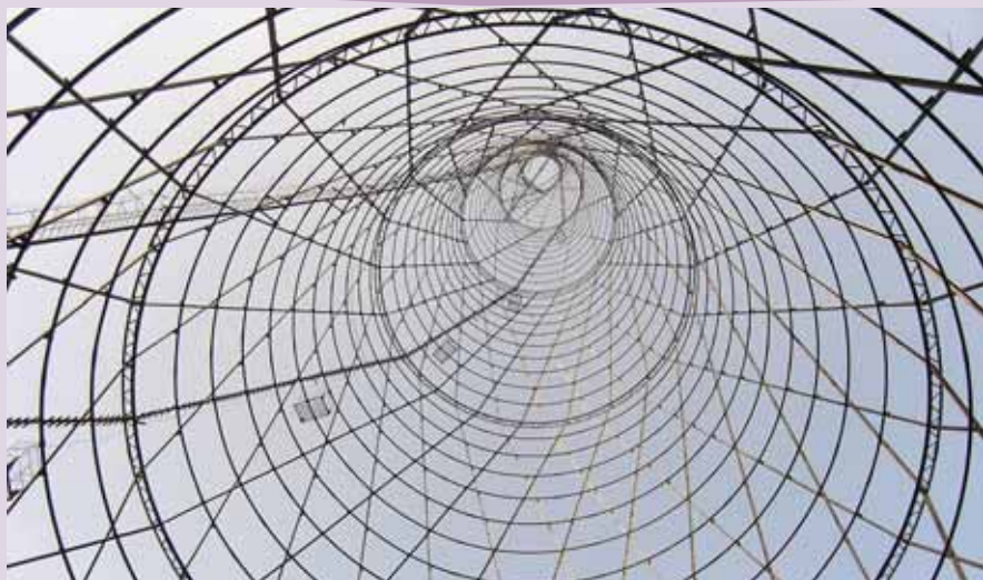
Восстановленная бывшая опора ЛЭП на берегу Оки у Дзержинска Former power transmission tower on the Oka river near Dzerzhinsk
